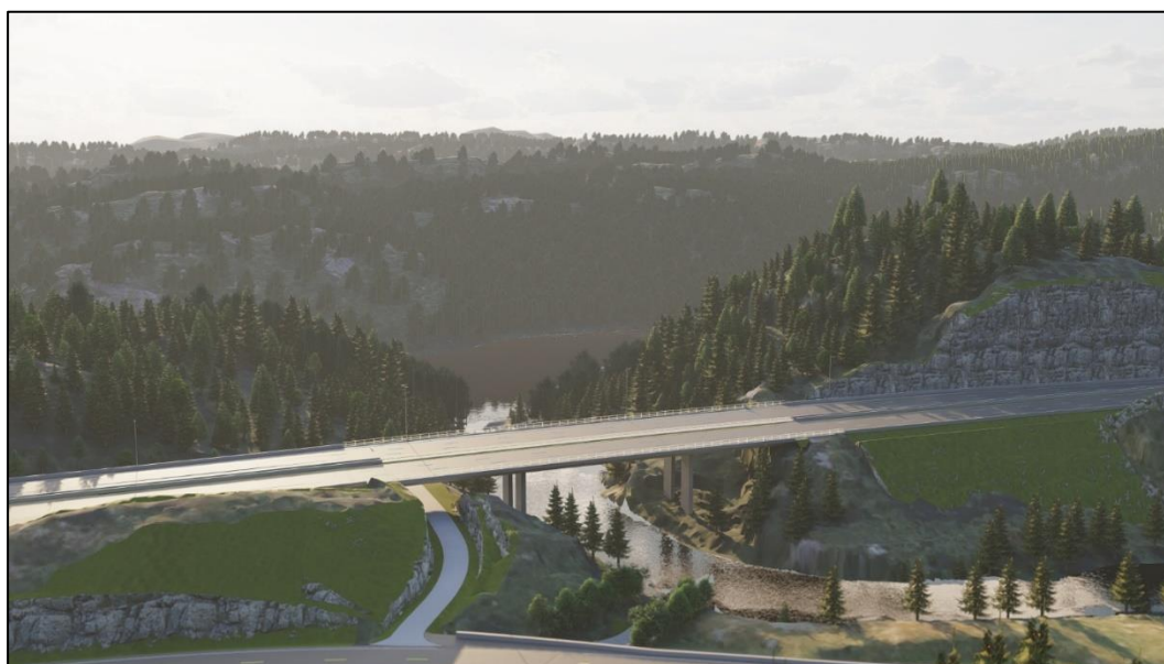
Figur 3-50. Bru over Frøitlandsfossen, sett mot Høylandsbotnen.
