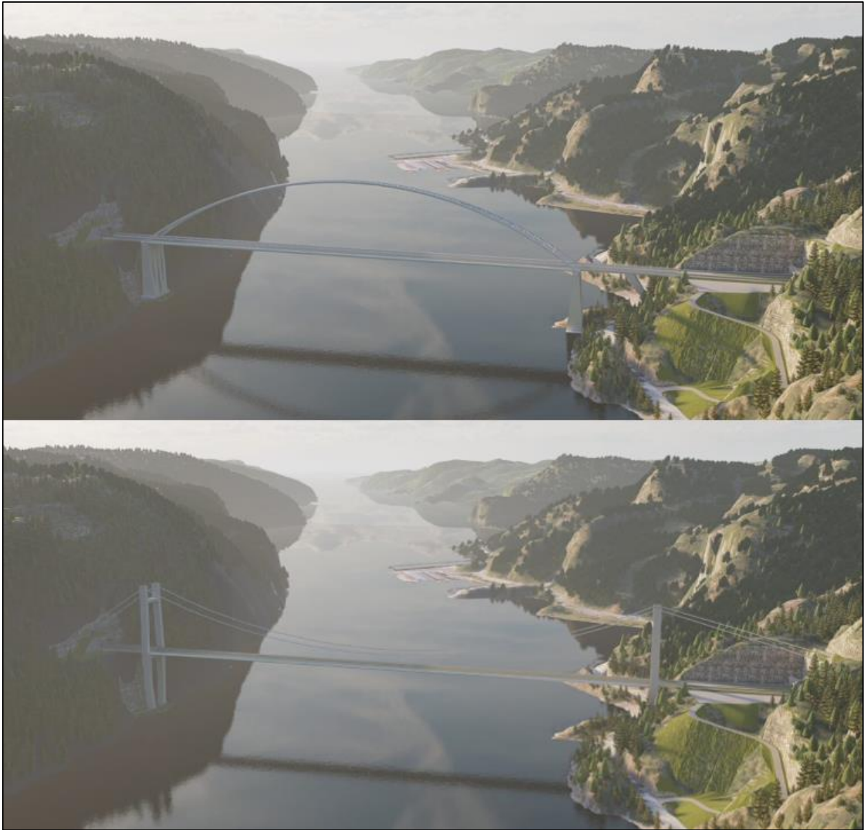
Figur 3-44. Over: Illustrasjon av netværksbuebru. Under: Illustrasjon av hengebru.
