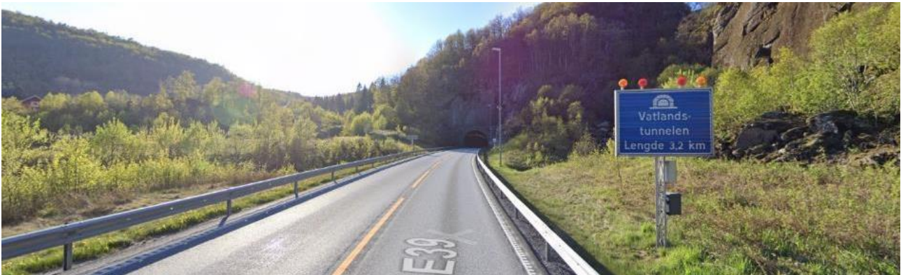
Figur 3-11: Vatlandstunnelen ved Rørdal. Kilde: Google Maps
