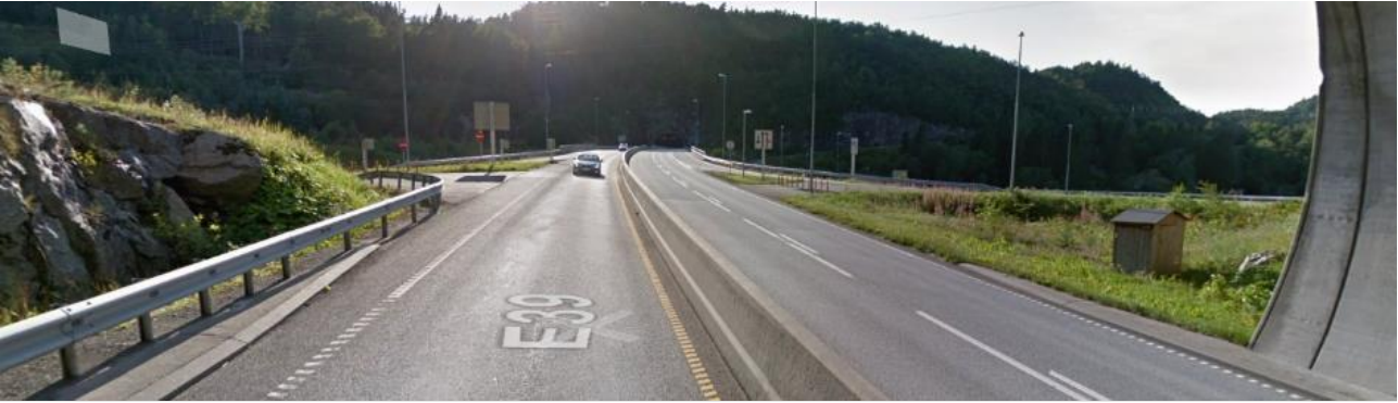
Figur 3-23: Lindlandskrysset. Kilde: Google Maps
