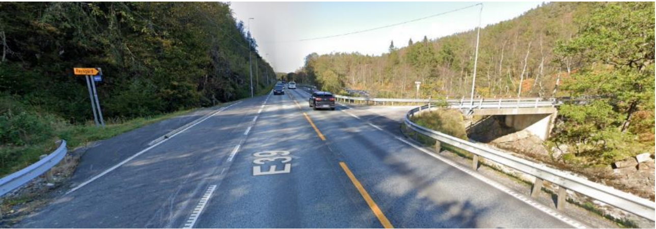
Figur 3-4: Dagens E39 ved avkjørsel til Røyskår. Kilde: Google Maps
