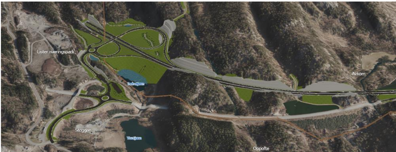
Figur 7-28: Høye bergskjæringer gjennom Hepte og Timbråsen til nytt kryssområde på Oppofte
