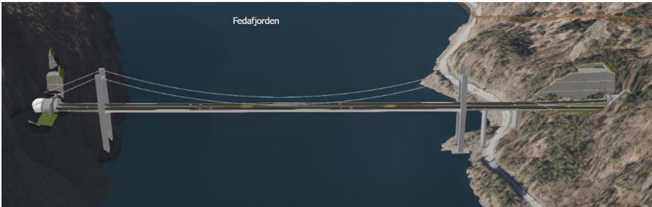
Figur 7-34: Ny hengebru over Fedafjorden til Skarpnes
