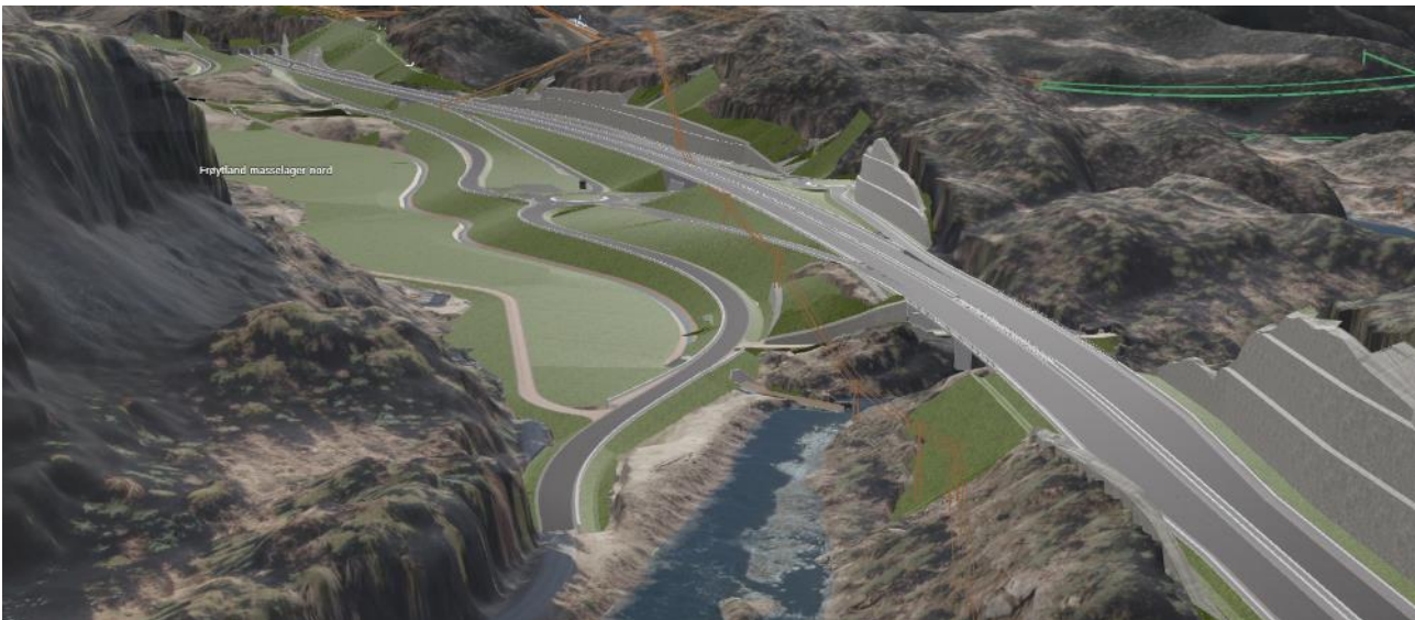
Figur 7-40: Nytt kryss på Frøytland sett fra Lona. Den omlagte Frøytlandsveien mot nord og ny seksfelts bru over Frøitlandsfossen
