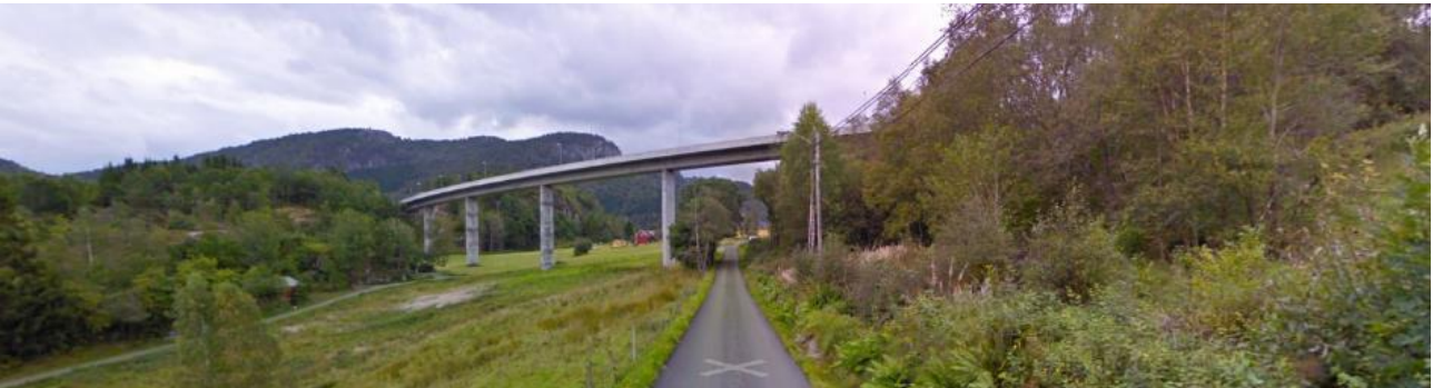
Figur 3-20: E39 på bru sett fra Melandsveien. Kilde: Google Maps
