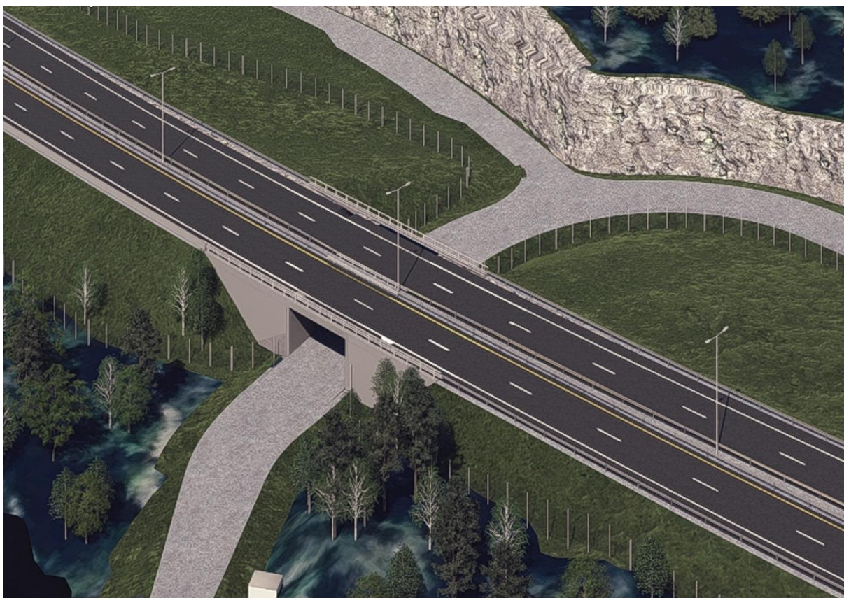
Figur 4-20 Rørholtveien under E18 i ny kulvert. (Kilde: Sweco)
