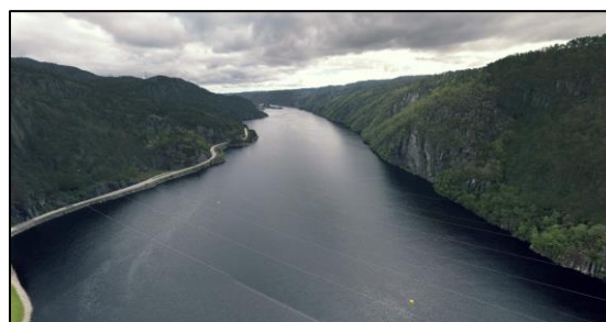
Figur 2-1 Landskapet ved Fedafjorden sett fra luftrommet ved eksisterende bru.
