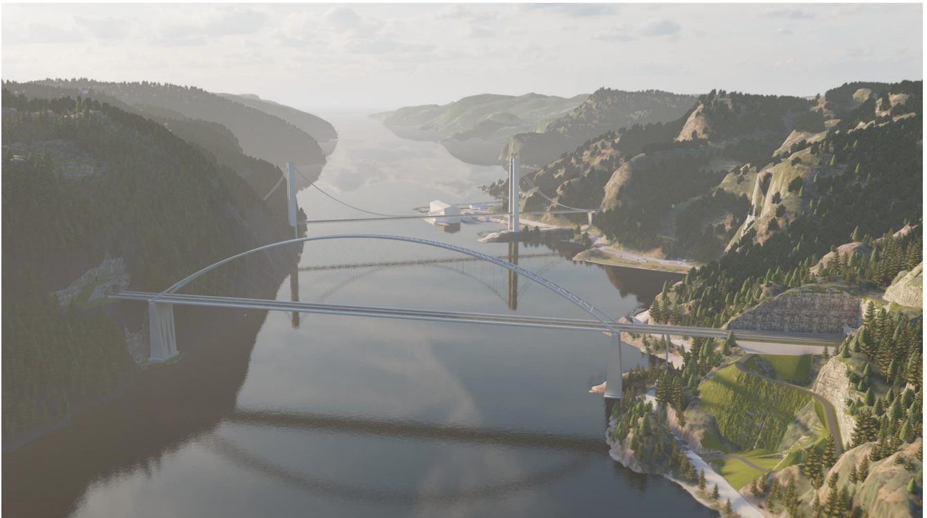
Figur 2-20 Utsnitt fra 3D-modell som viser nettverksbuebru over Fedafjorden.
