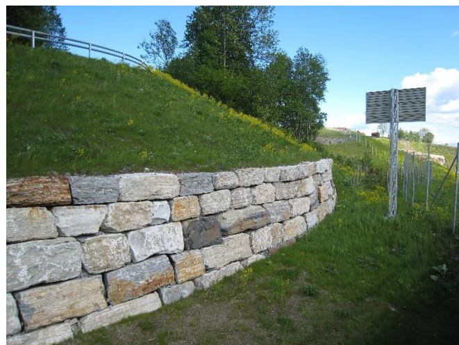
Figur 2-19 Natursteinsmur i forbindelse med E16 Bjørum-Skaret. Foto: SVV
