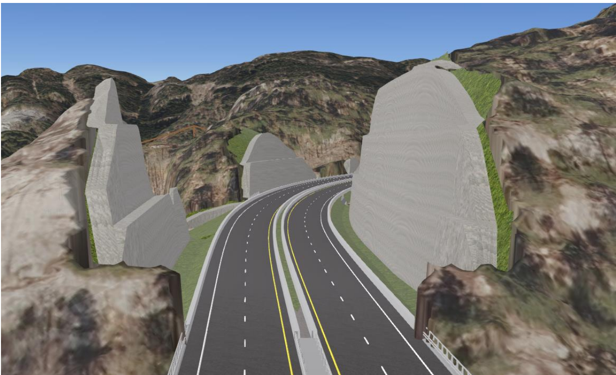
Figur 2-8 Fjellskjæringer vest for Avkom utføres med paller og fanggrøft samt rekkverk langs veien.
