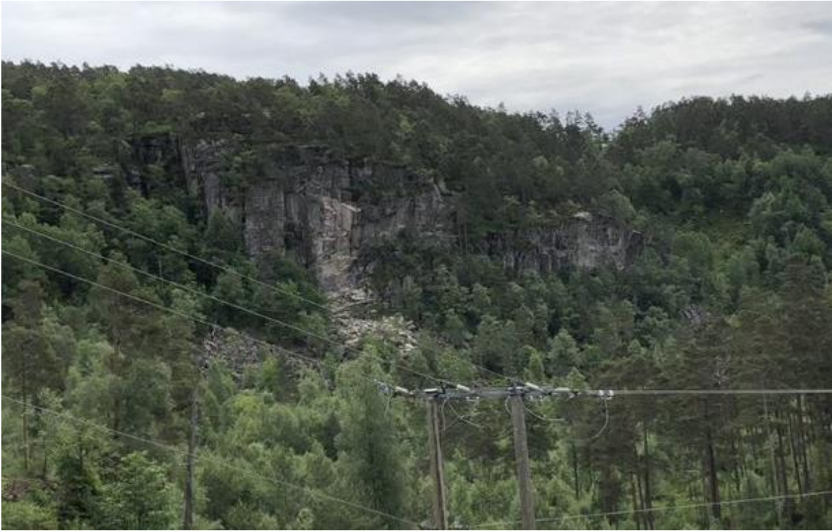
Figur 73: Steil bergside langsmed planlagt kryss på Oppofte. Det er synlig et ferskt mindre steinskred fra siden. Det ligger ur langsmed hele siden.
