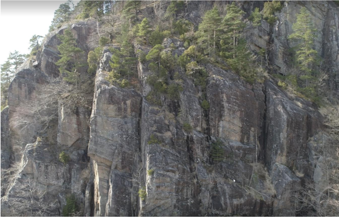
Figur 63: Bilde tatt mot SV. Viser vertikale sprekker med stor utholdenhet.
