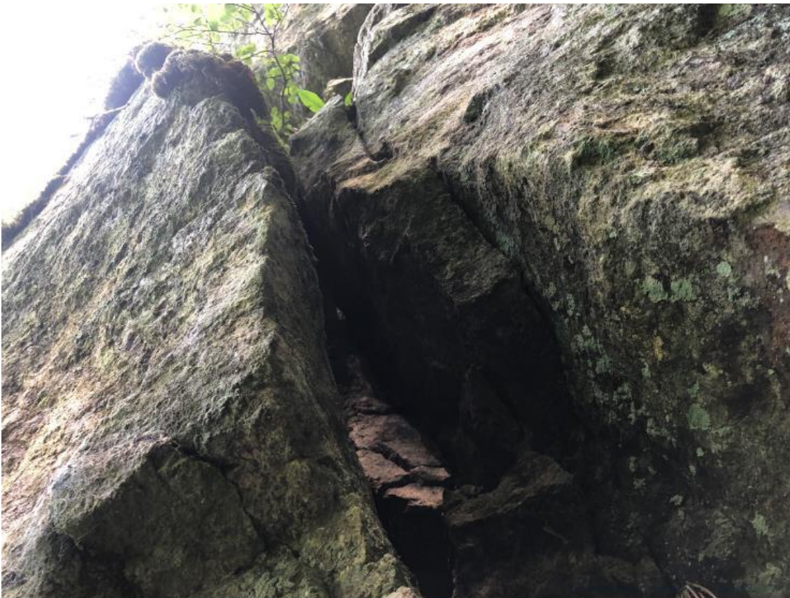
Figur 50: Bergblokk med åpen baksprekk over påhugget.
