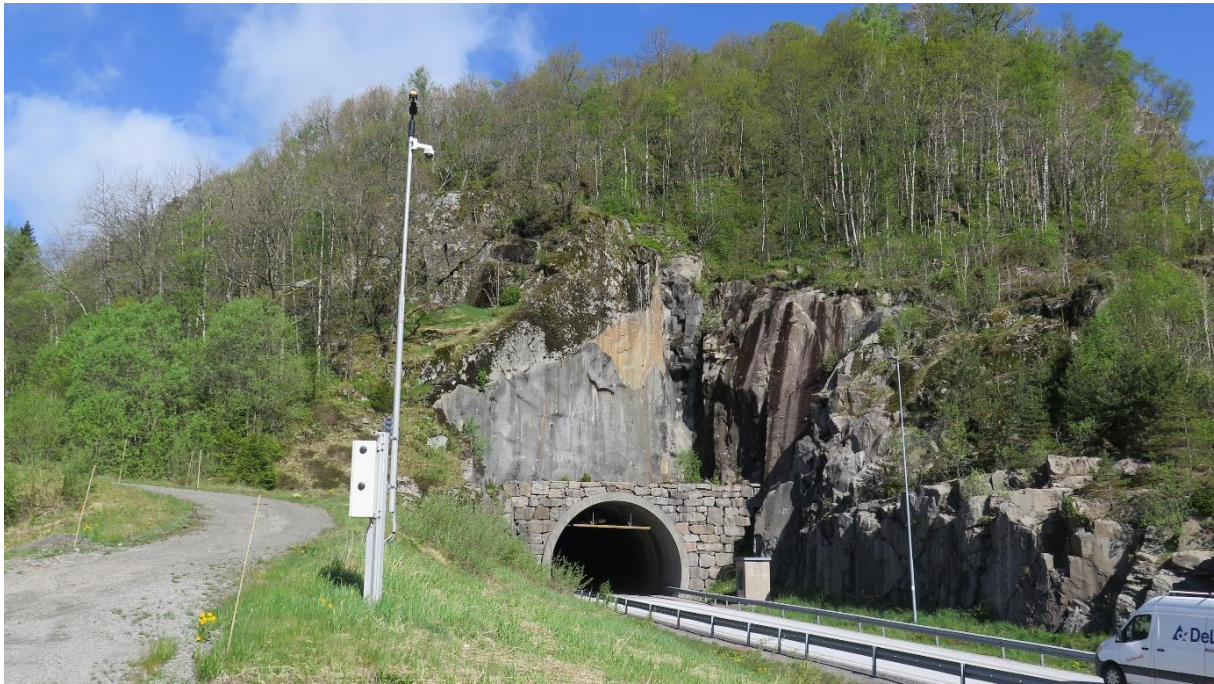
Figur 81: Eksisterende påhugg. Nytt påhugg skal legges til venstre for eksisterende, noe lenger inn i siden for å oppnå tilstrekkelig bergoverdekning.
