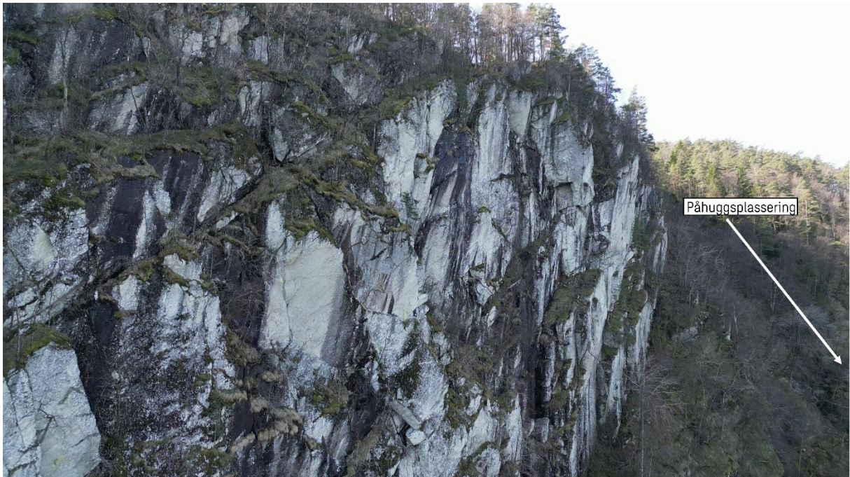
Figur 48: Steil bergside på oversiden av påhugget. Samme som i Figur 47, sett mot SØ.
