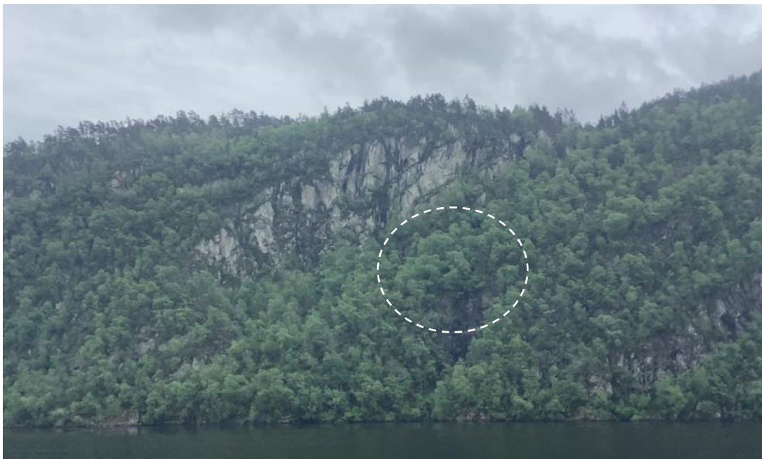
Figur 46: Bilde av sørlig side av fjorden, hvor påhugg til Espedalstunnelen er planlagt. Påhugget planlegges under den vegetasjonsfrie bratte skrenten. Omtrentlig plassering av påhugget i hvitt.
