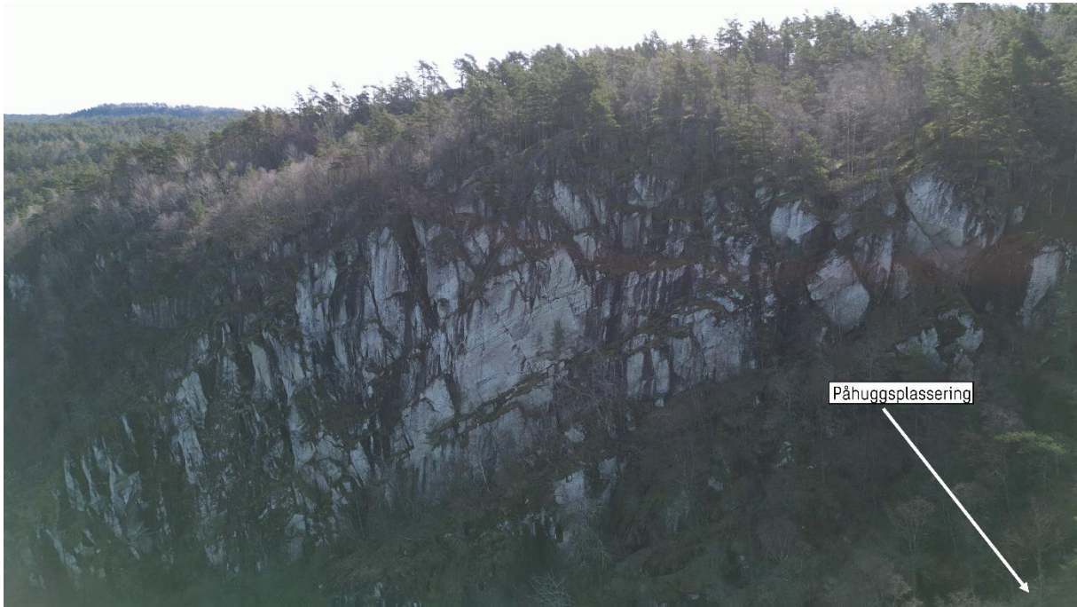
Figur 47: Steil bergside på oversiden av påhugget. Sett mot S.
