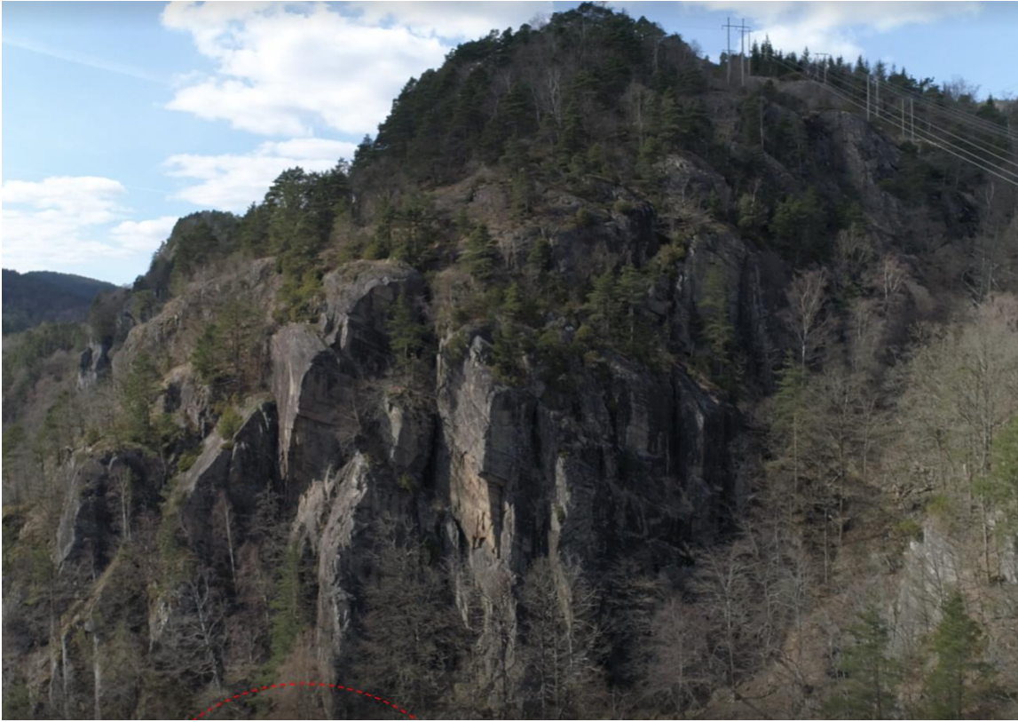
Figur 59: Påhugget legges i venstre flanke av søkket, omtrentlig plassering markert i rødt. Bilde tatt mot V.
