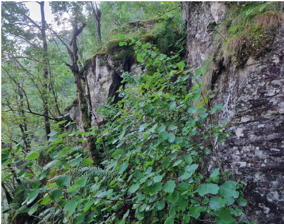
Figur 52: Mellom forskjæringen og brufundamenter. Det er observert enkelte avløste blokker.
