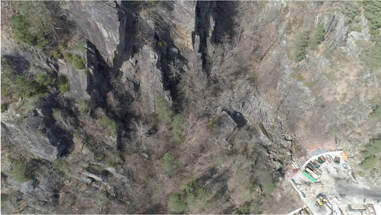
Figur 61: Bergsiden sett ovenfra.
