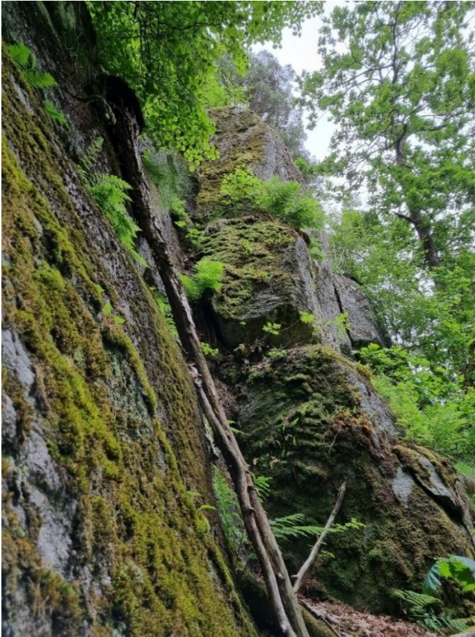
Figur 40: Bergblotning ovenfor påhugg, med steilt sprekkesett.
