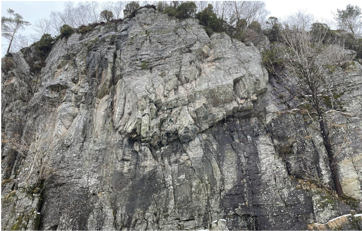
Figur 13: Bergskrent ved Åsefjellet. Bildet er tatt mot nordøst ved ca. profil -300.
