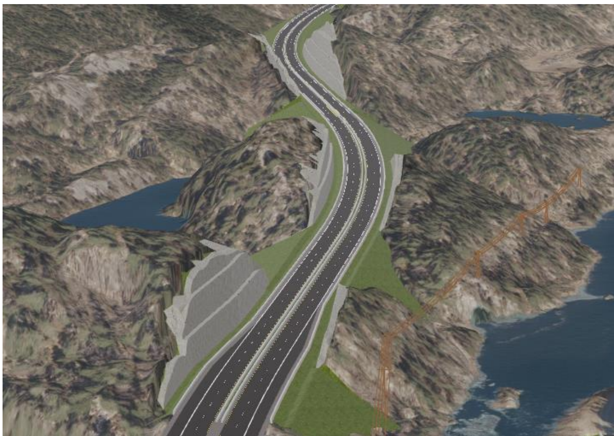
Figur 57: Utklipp fra innsynsmodellen som viser planlagte skjæringer mellom profil 18100-19115. Utsnittet er tatt i retning nordvest (stigende profilnummer).
