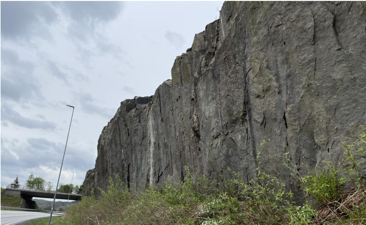
Figur 35: Eksisterende veiskjæring ved ca. profil 5150. Bildet er tatt mot øst.
