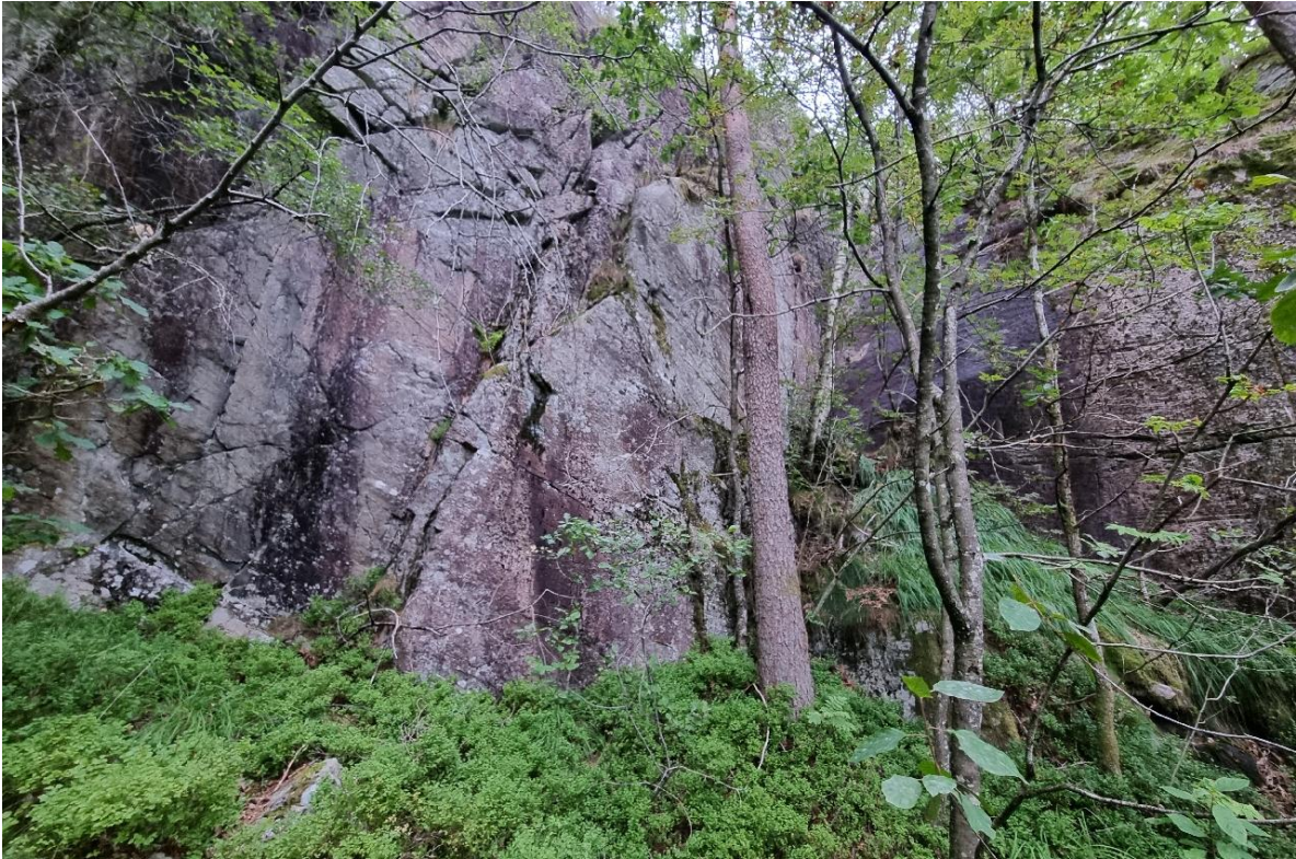
Figur 53: Bergskrent ved ca. profil 17200, ca. 50 m vest for kryssområdet. Bildet er tatt mot nord.
