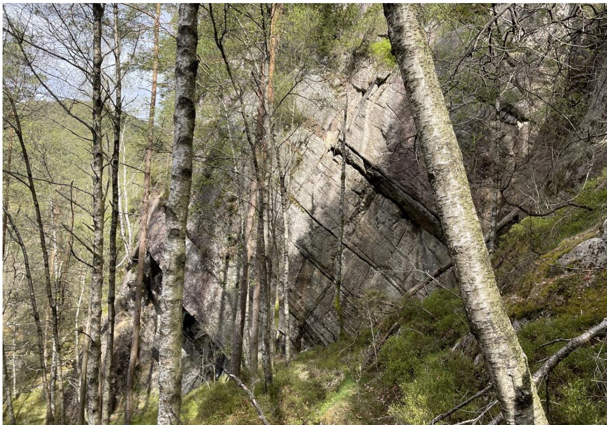
Figur 61 Litt vest for skjæring E39-22-VS og E39-23-HS. Bergskrent som tilhører sprekkeseett 2, der sprekkeseett 1 og 3 kan observeres i skrenten.
