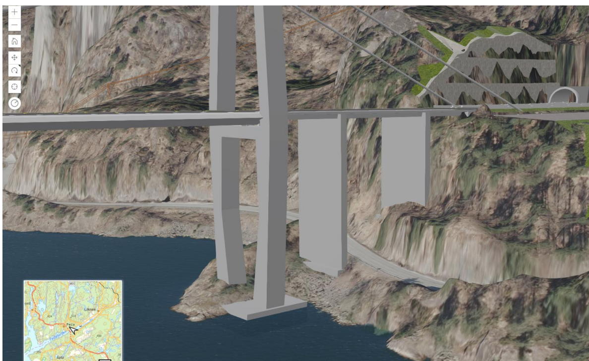
Figur 16: Utklipp fra modell som viser alternativ 2 hengebru med fundament på Skarpnes. Sett mot nordvest.
